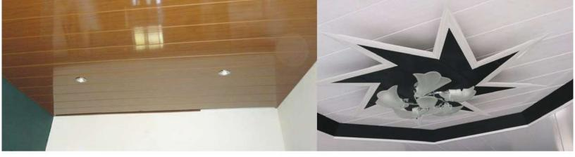
Nuestro novedoso sistema de construcción liviano para cielo raso, está compuesto por láminas de PVC (policloruro de vinilo) rígido extruido de 30 cm de ancho, largo de 5.95 mts y espesor de 9 mm.
